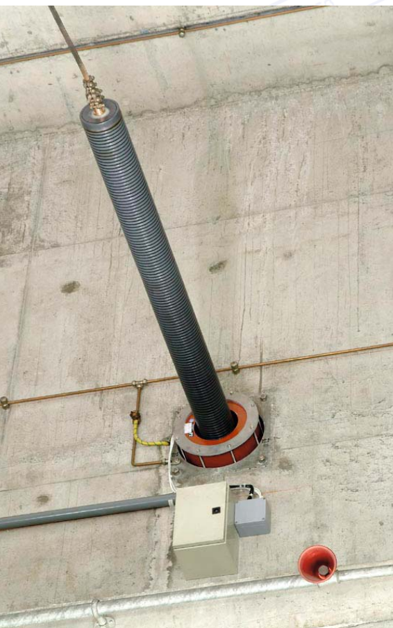
Bucha de passagem Wall bushing Buje pasamuro 145 kV - 400 A
